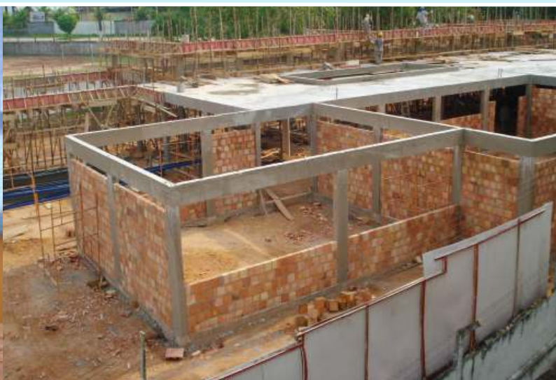
Construção do Núcleo de Tecnologia do Gás Natural
